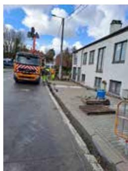
Dans le cadre de la protection des habitations dans le bas de la rue de Huleu, le service travaux a réalisé un nouveau trottoir sur 130m<sup>2</sup>, récupération des eaux pluviales avec la pose de caniveaux, réhausse du trottoir et remplacement des bordures. Merci à toute l'équipe pour ce beau travail.
