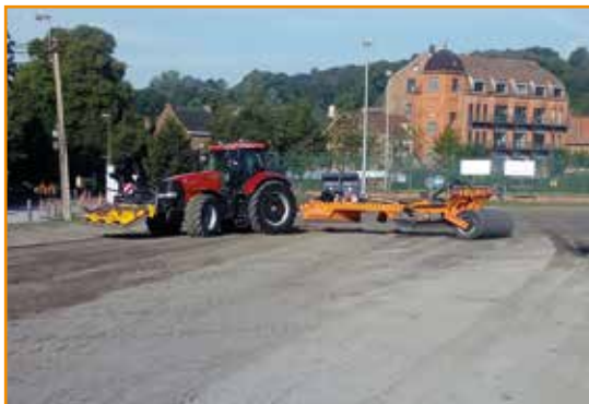
Aménagement du parking de la rue Jean Jolly
