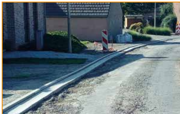
Après cette période de congé, les travaux de la rue de l'Ascension ont repris, ils sont en bonne voie.
