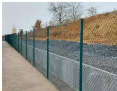
Installation de « L de soutènement » et réalisation d'une bande de drainage le long du terrain de centre Omnisport afin d'éviter les coulées de boues.
