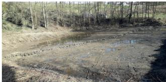
La **Zit du Ry du Mortier**, créée à l'initiative de la Direction des routes lors des travaux d'aménagement, recueille les eaux de son versant mais également des eaux venant de la chaussée de Nivelles et de l'entrée du ring. **Capacité : 5.000 m<sup>3</sup>**
